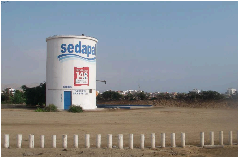
Figure 4. Réservoir de Sedapal à San Bartolo qui permet d'alimenter les camions-citernes
