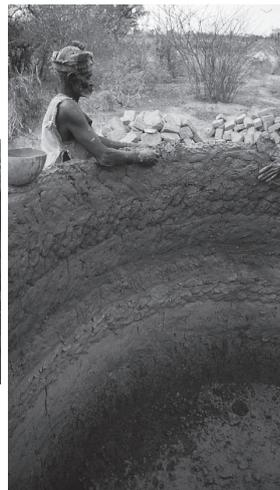
1 Le maçon de gauche s'est retourné. Il construit un tronçon de la même forme (parallépipède, grande base en bas) que celui d'ouverture d'une nouvelle assise. Le second maçon, avec l'eau coulant de sa main, s'apprête à lisser le tronçon sur lequel il travaille.
