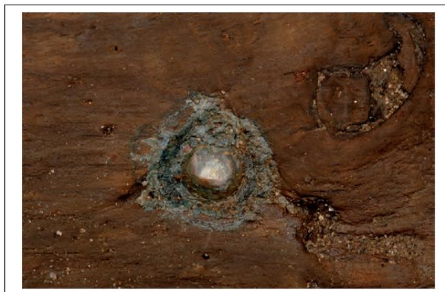
Fig. 244. Détail de la tête d'un clou en cuivre chassé dans une encoche triangulaire dans le bordage MR1264-55 (cl. Chr. Durand - CCJ).
