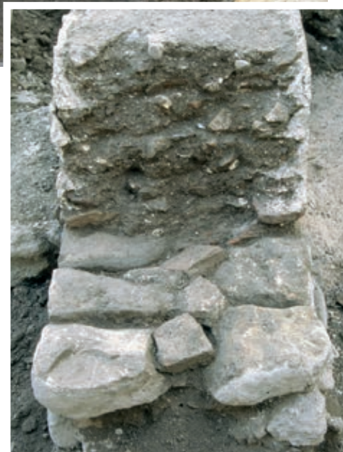
Fig. 76. Vue d'un mur en terre banchée en cours de démontage (cl. M. Derain/Inrap).
