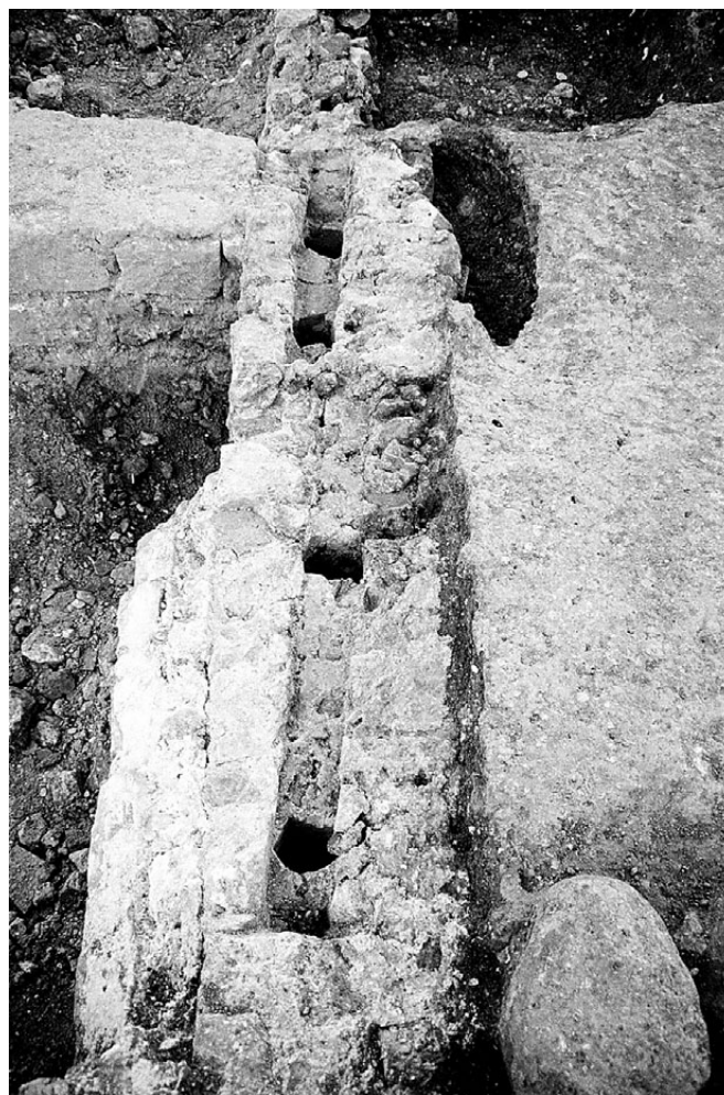
Fig. 85. Série de pieux en bois noyés dans le blocage d'un mur de cave témoignant des dispositifs d'étaie lors de la construction en sous-œuvre des caves (cl. M. Derain/Inrap).
