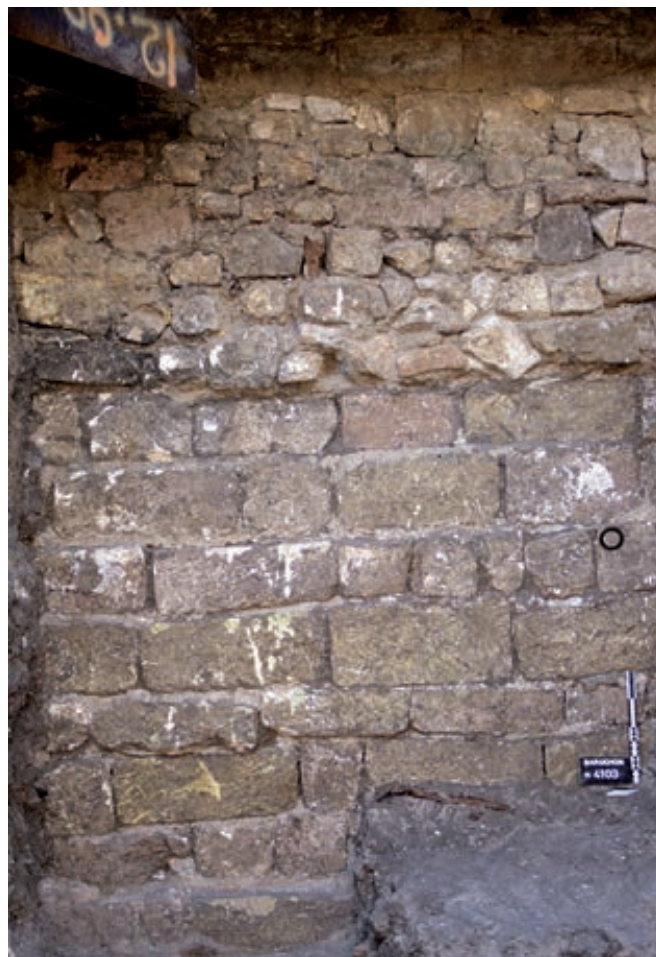
Fig. 141. Vue de la maçonnerie en moyen appareil de calcaire rose, sous le palais Daviel (cl. T. Maziers/Inrap).
