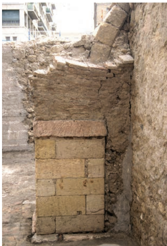
Fig. 208. Le pilier central de la cave de la parcelle 357 vu de l'ouest (cl. M. Derain/Inrap).
