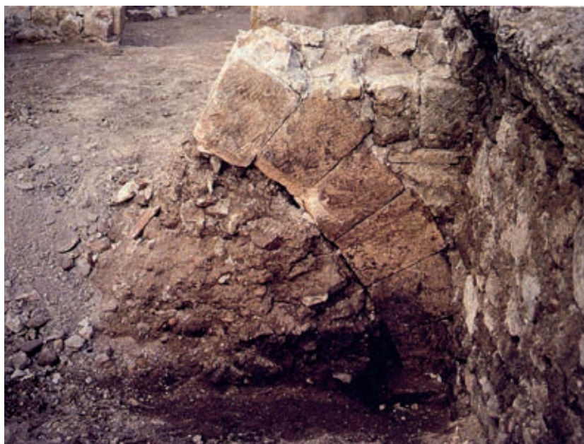
Fig. 205. Départ nord de l'arc doubleau-diaphragme de la cave non terminée de la parcelle 387 (cl. M. Derain/Inrap).
