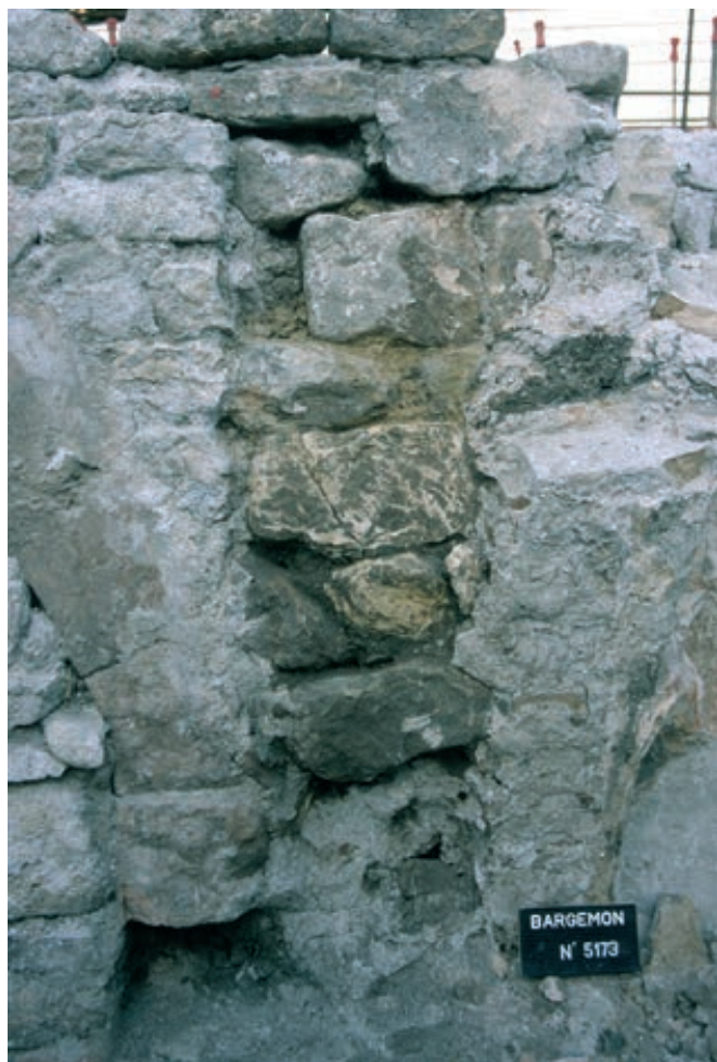
Fig. 153. Mur médiéval pris entre deux maçonneries modernes (cl. T. Maziers/Inrap).
