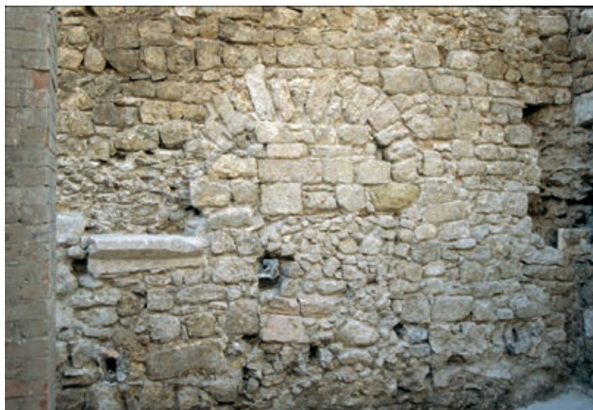
Fig. 164. Vue de la porte de l'unité D (cl. M. Derain/Inrap).
