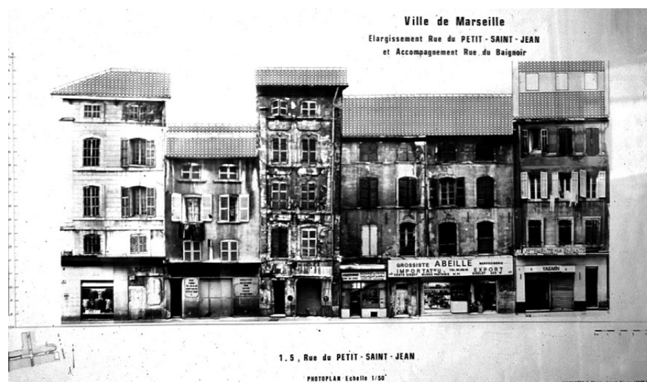
Fig. 102. Photo-relevé de la façade nord de la rue du Petit-Saint-Jean antérieure à la démolition des îlots (Atelier du Patrimoine/Ville de Marseille).
