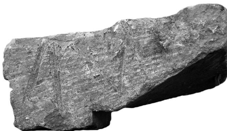
Fig. 79. Traces de taillant brettelé sur l'une des faces d'un claveau d'arc avec arrière-voissure (cl. M. Vacca-Goutoulli).
