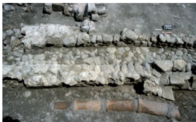
Fig. 62. Premier caniveau dans la rue de la Guirlande (XVI e s.) (cl. F. Parent/Inrap).
