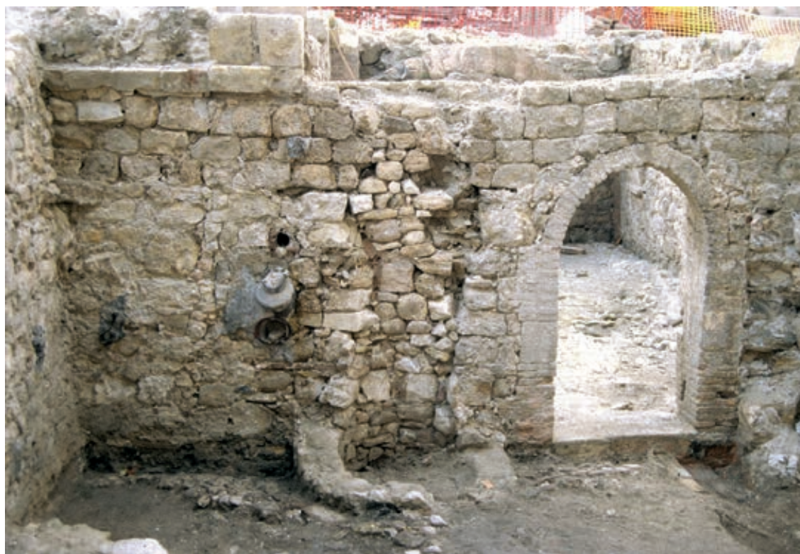
Fig. 204. Parfaite intégration de la porte dans le mur qui sépare les caves de la parcelle 358 (cl. M. Derain/Inrap).
