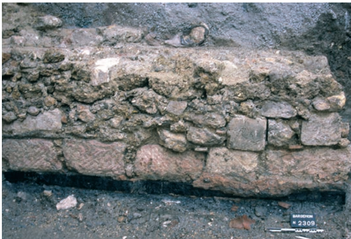
Fig. 219. La fondation de la façade de l'Hôtel de Rome d'Ardenne (cl. T. Maziers/Inrap).
