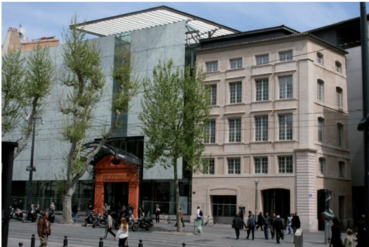
Fig. 37. La façade de l'actuelle bibliothèque de Marseille qui intègre l'ancienne façade sur le Cours (cl. B. Sillano/Inrap).
