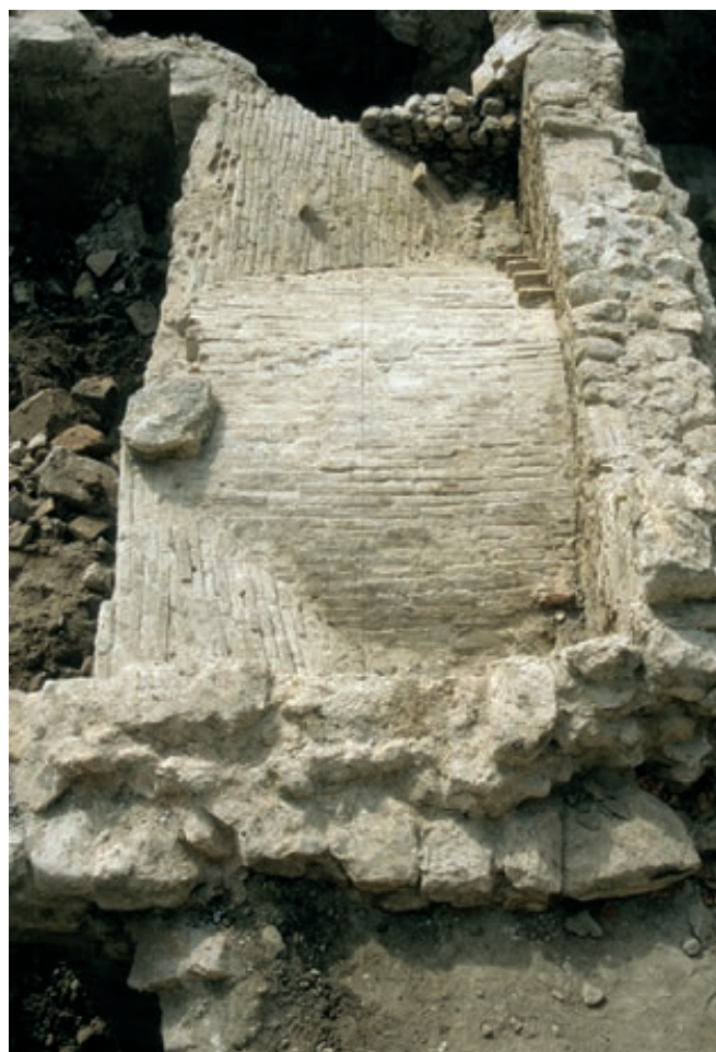
Fig. 87. Extrados d'une voûte d'arêtes en briques sur une cave (cl. M. Derain/Inrap).
