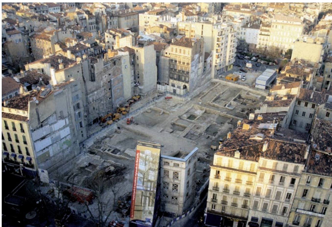
Fig. 8. Le chantier de l'Alcazar (cl. F. Parent/Inrap).
