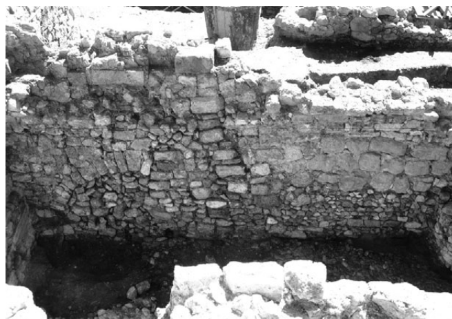
Fig. 168. Maçonneries divisant l'unité B (cl. M. Derain/Inrap).
