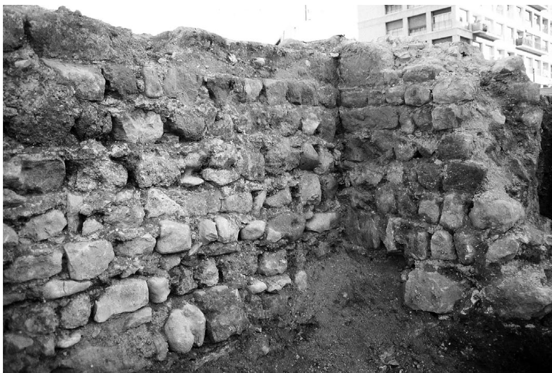
Fig. 217. Le mur de façade nord (à gauche) et le refend de la parcelle 386 (cl. M. Derain/Inrap).
