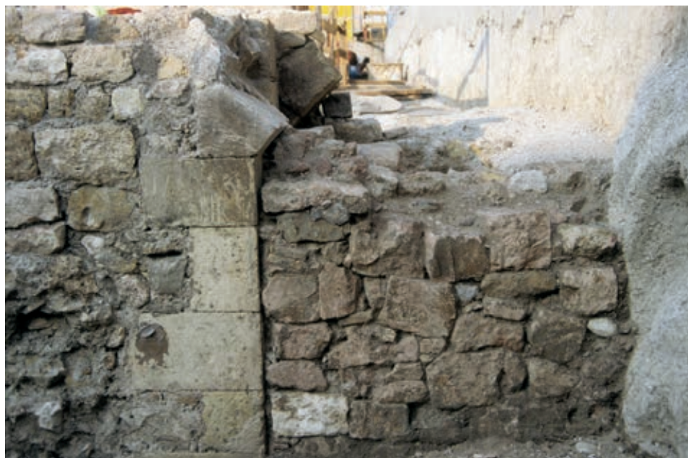
Fig. 188. Extension de la cave sous la rue de la Guirlande (cl. N. Nin/Inrap).
