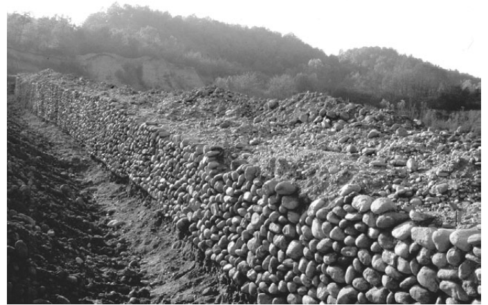
Fig. 72. Canal en galets destiné au tri des alluvions (photographie A. Vaudagna).
