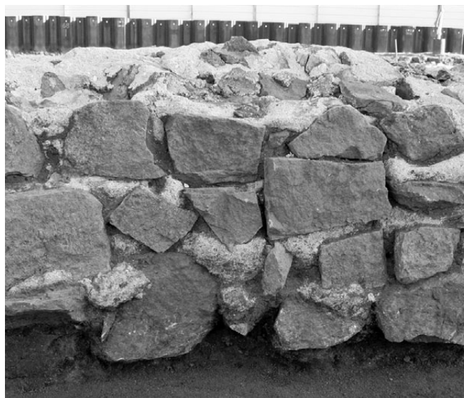
Fig. 26. Détail du parement nord du mur MR2004.
