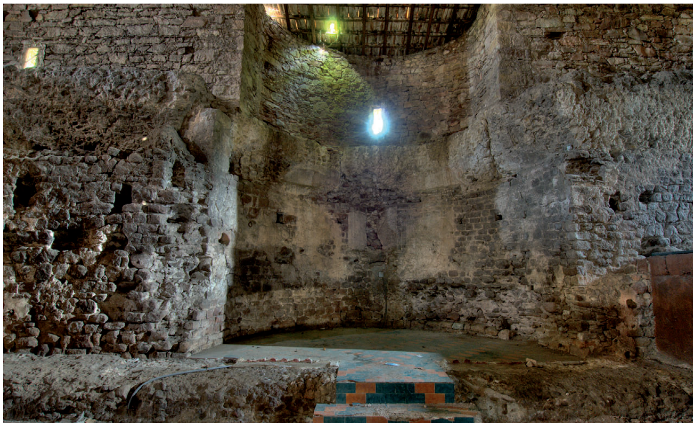
Fig. 57. Vue de l'intérieur de la grande salle des thermes (Cl. Ville de Fréjus - R. Hacquard®).
