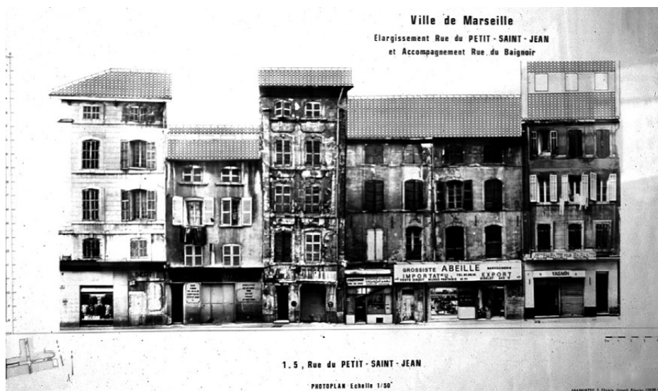
Fig. 102. Photo-relevé de la façade nord de la rue du Petit-Saint-Jean antérieure à la démolition des îlots (Atelier du Patrimoine/Ville de Marseille).
