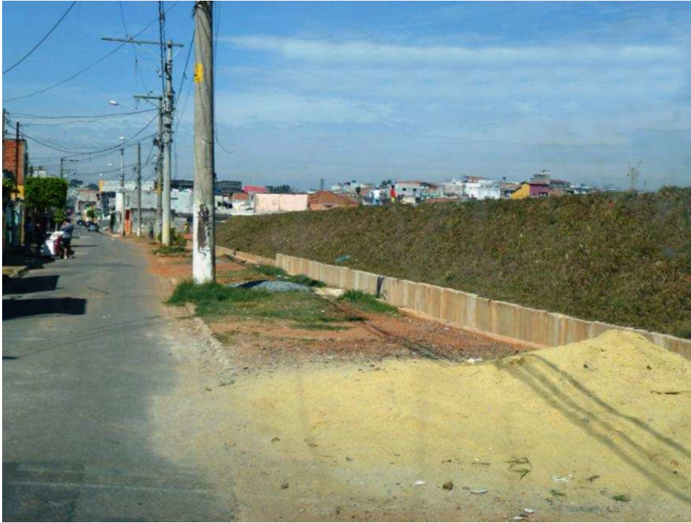
Figure 13 Digue censée protéger le lotissement des inondations
