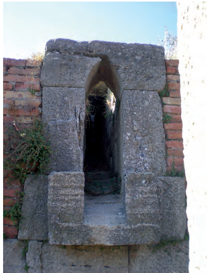
Fig.13. Apollonia d'Illyrie, façade extérieure de la galerie (cliché S. Bouffier).
