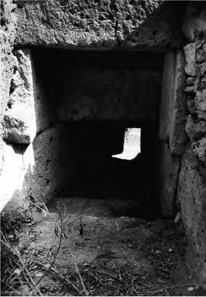
Fig. 9. Sélinonte, égout de la rue SbE (cliché S. Bouffier)
