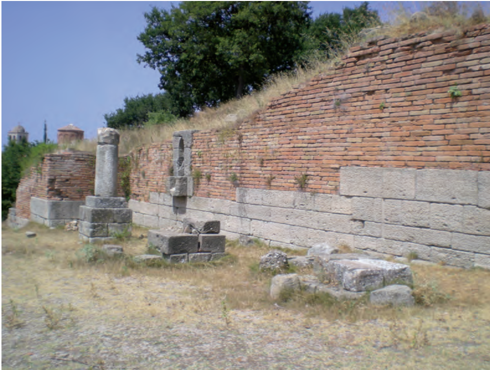
Fig. 11. Apollonia d'Illyrie, la galerie d'évacuation couverte dans la fortification (cliché S. Bouffier).
