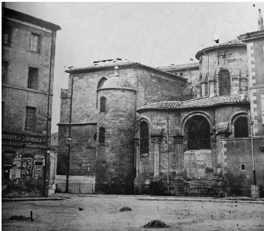
Ill. 5 : Détails de la cathédrale Saint-Appollinaire de Valence. Le chevet non encore dégagé : à droite la maison Milhan ; à gauche du chevet, la sacristie et sa tourelle extérieure (escalier). André Blanc, La Cathédrale de Valence, témoin de l'humanité romane , Valence, éd. Peuple Libre, 1984, p. 77.
