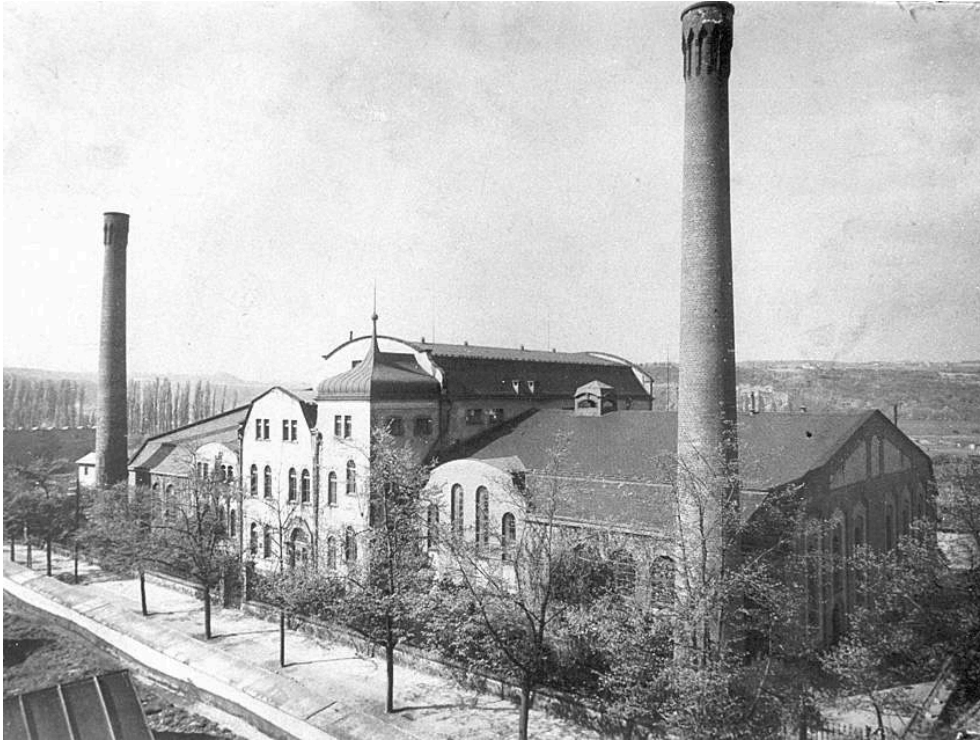
Fig.1. Station d'épuration des eaux usées de Prague
