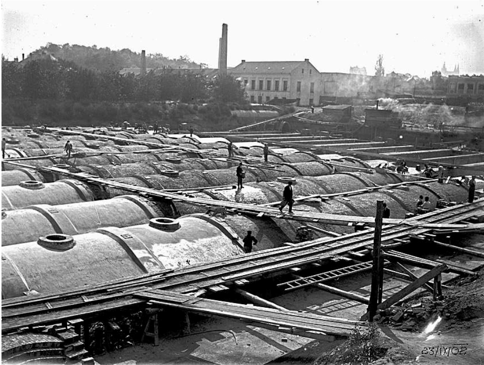
Fig. 4. Station d'épuration. Les bassins de décantation
