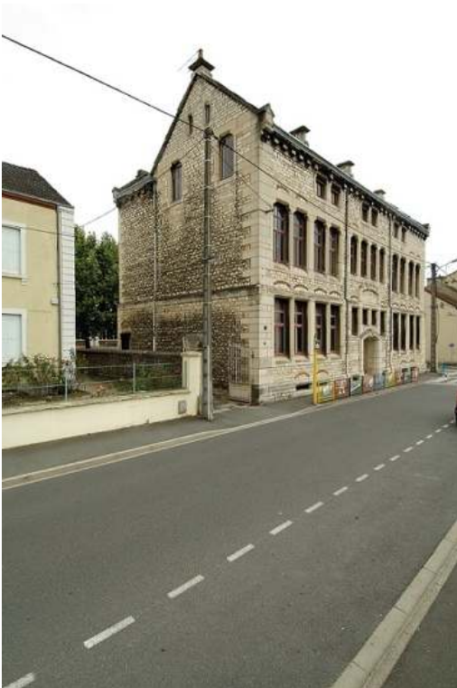
Fig3b. Maison d'école de Montceau-les-Mines
