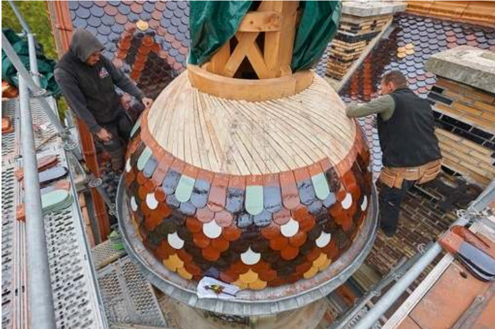
Fig.10a. Restauration du lanternon de la villa Perrusson
