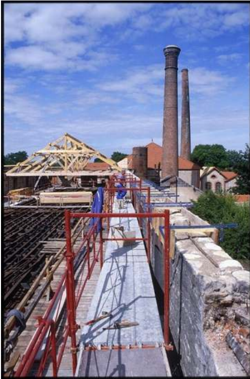
Fig.7a. La briqueterie de Ciry-le-Noble en cours de restauration
