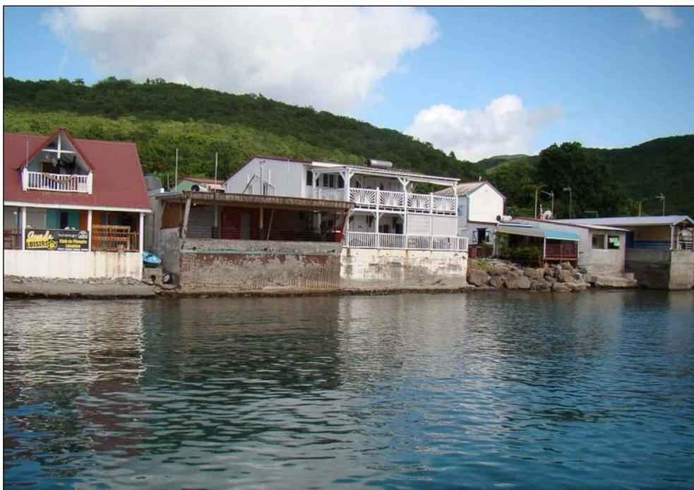
Cette photographie illustre les méthodes d'autoprotection des maisons par mur en béton et par un étage. En 1997, il ne restait de la plage initiale qu'un liseré de galets de 1,5 m de large. En 2018, la plage a disparu depuis une quinzaine d'années.
