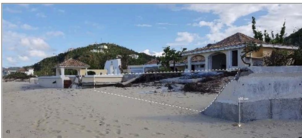
Illustration 8d - Impacts morphologiques de l'ouragan Irma à Baie Rouge (St Martin) : dommages caractéristiques des vagues cycloniques sur les infrastructures et habitations côtières
