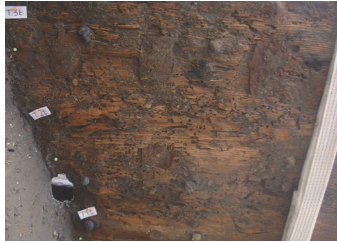
Fig. 10 : Vue de la surface extérieure de la coque de Napoli A au niveau du flanc tribord : les languettes de liaison entre les virures du bordé sont bien visibles tandis que le bois est très rongé par les organismes xylophages (cliché G. Boetto).
