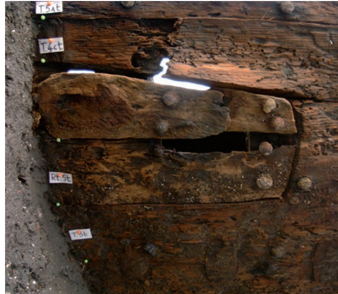
Fig. 33 : La planche de réparation Rt5t (cliché G. Boetto).
