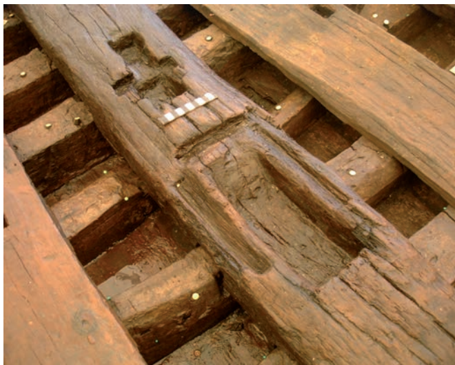
Fig. 26 : Vue depuis nord-ouest des encoches présentes sur la face supérieure de la carlingue/massif d'implanture du mât. L'encoche plus grande, en premier plan, était destinée à accueillir le pied du mât. Elle est entourée d'entailles pour le logement du fourreau d'étambrai (cliché G. Boetto).
