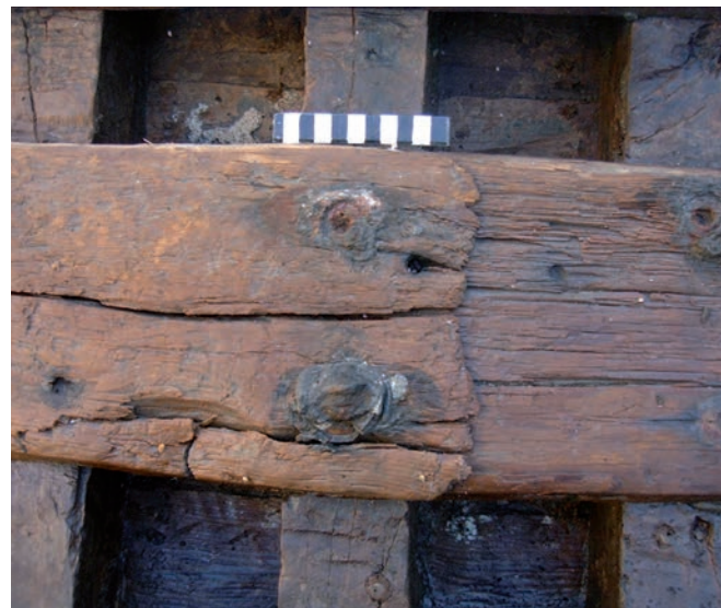
Fig. 27 : Détail d'un assemblage de deux bordages composant une serre. Les extrémités sont ajustées l'une sur l'autre, puis fixées sur la membrure par deux clous en fer (cliché G. Boetto).
