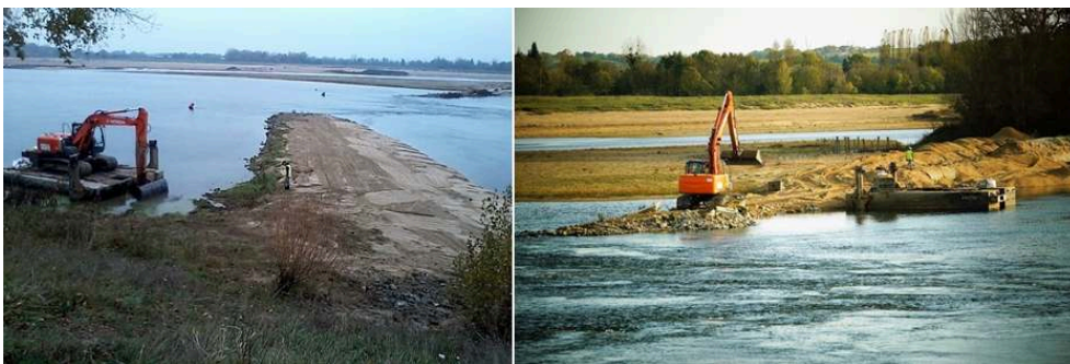
Figure 3. Travaux de remodelage des seuils du Fresne
