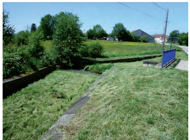
Fig. 19. Pédiluve contemporain : vue vers le nord du pédiluve d'Azoudange aménagé dans le cours du ruisseau des Basses, route départementale D955 (photo : M. Mondy, Inrap).
