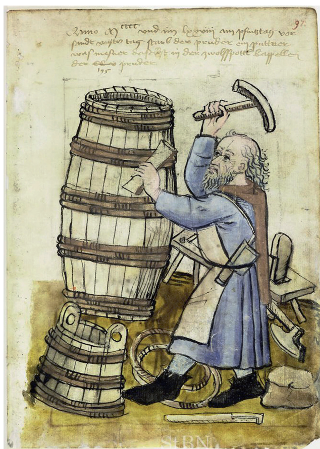
Fig. 17. Un tonnelier (sans nom) cerclant un tonneau avec une chasse et un maillet; Germanischen Museum Nürnberg Hausbuch, Amb 317-2, Mendel II, f o 97r, vers 1478 ( www.nuernbergerhausbuecher.de ).
