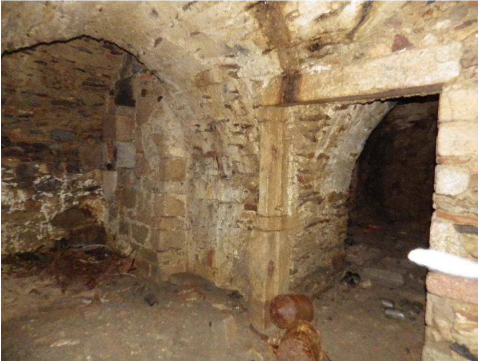
Fig. 2 – Cave du n° 19, rue du Consulat
