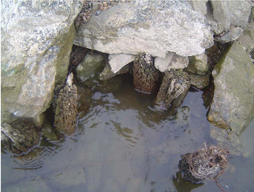
Fig. 3 – Pieux et leur blocage de pierres
