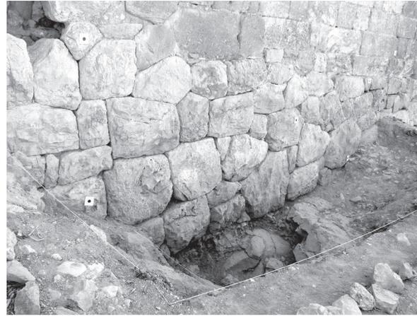
Figure 3. L'appareil polygonal
