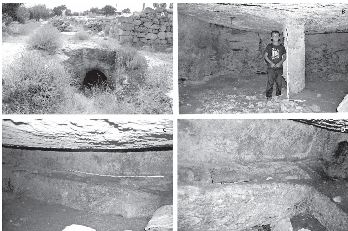
Tombe 32 : A) vue extérieure; b) pilier central; c) banquette de la paroi sud; d) cuve et niche latérale
