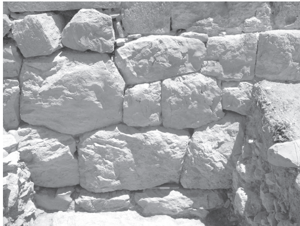
Figure 3. Sondage au pied de la muraille à l'extérieur de la citadelle, détail du parement du socle en polygonal dont le sommet comporte un palier. La maçonnerie repose directement sur le rocher © Mission syro-libanaise de Cyrhus-Nebi Hourri.
