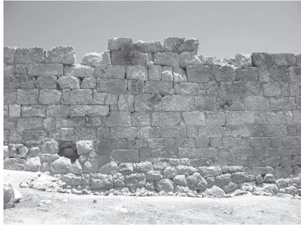
Figure 2. Citadelle, rempart méridional, parement externe (vue vers le nord). L'appareil en polygonal compose le socle avec paliers, parfois altérés ; l'élévation est postérieure (période byzantine) © Mission syro-libanaise de Cyrhus-Nebi Hourri.
