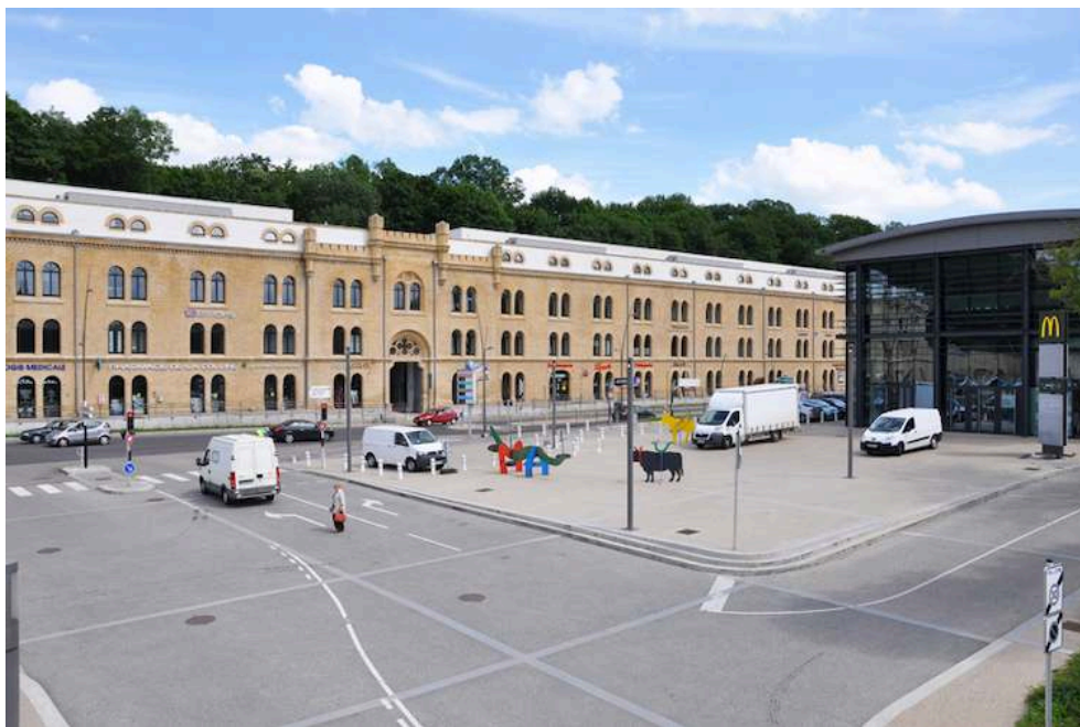
Figure 5. Les casernes Steinmetz réhabilitées
