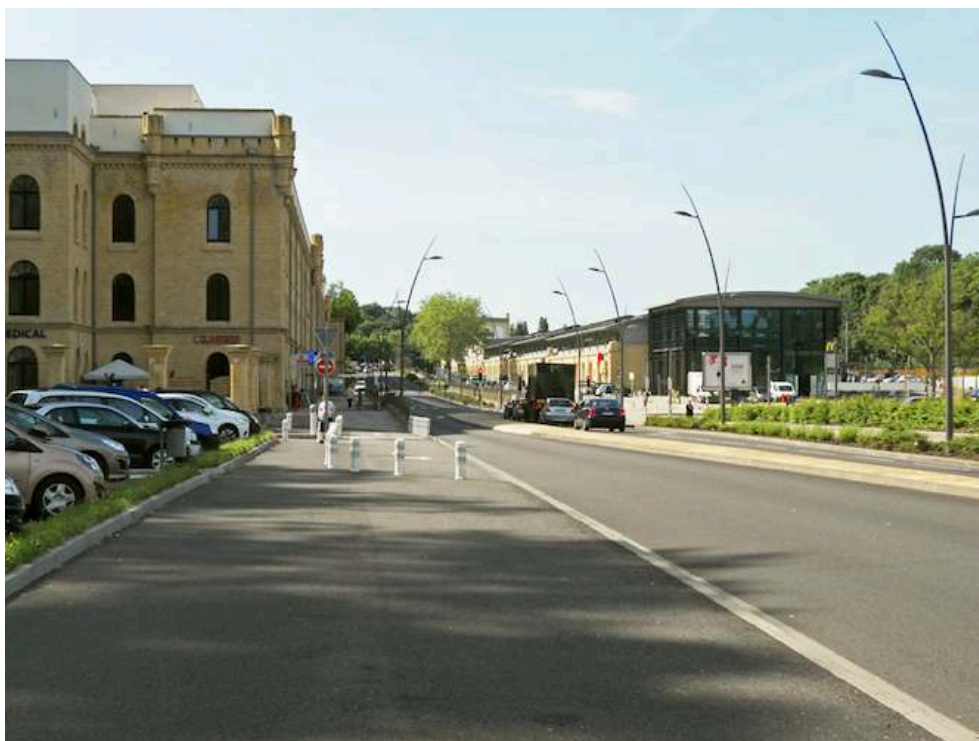
Figure 3. Les casernes Steinmetz bordant le boulevard de Trèves
