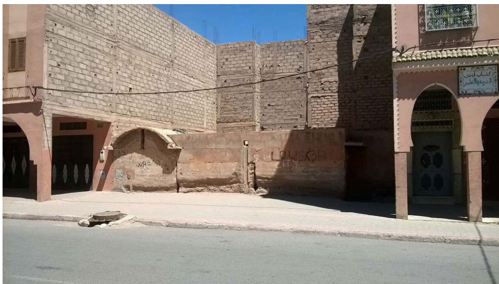
Fig. 2. – Le site du projet de Ouarzazate en avril 2018.
