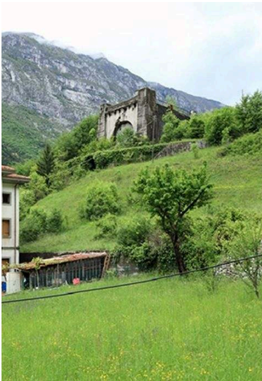
Figure 4. L'arcade dont sortaient les conduites de l'ancienne centrale de Nove
