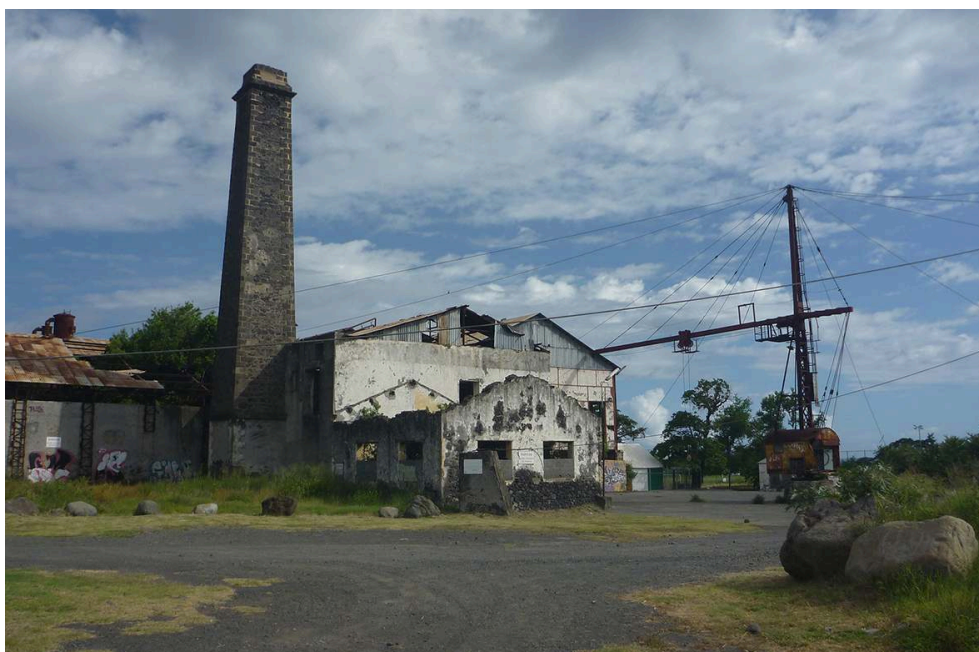
Fig. 2 – Vue de certains bâtiments conservés et d'une grue de l'usine, au moment du diagnostic
