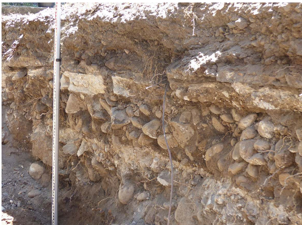
Fig. 5 – Vue en coupe de 2 sols en mortiers superposés observés dans le sondage n° 15
