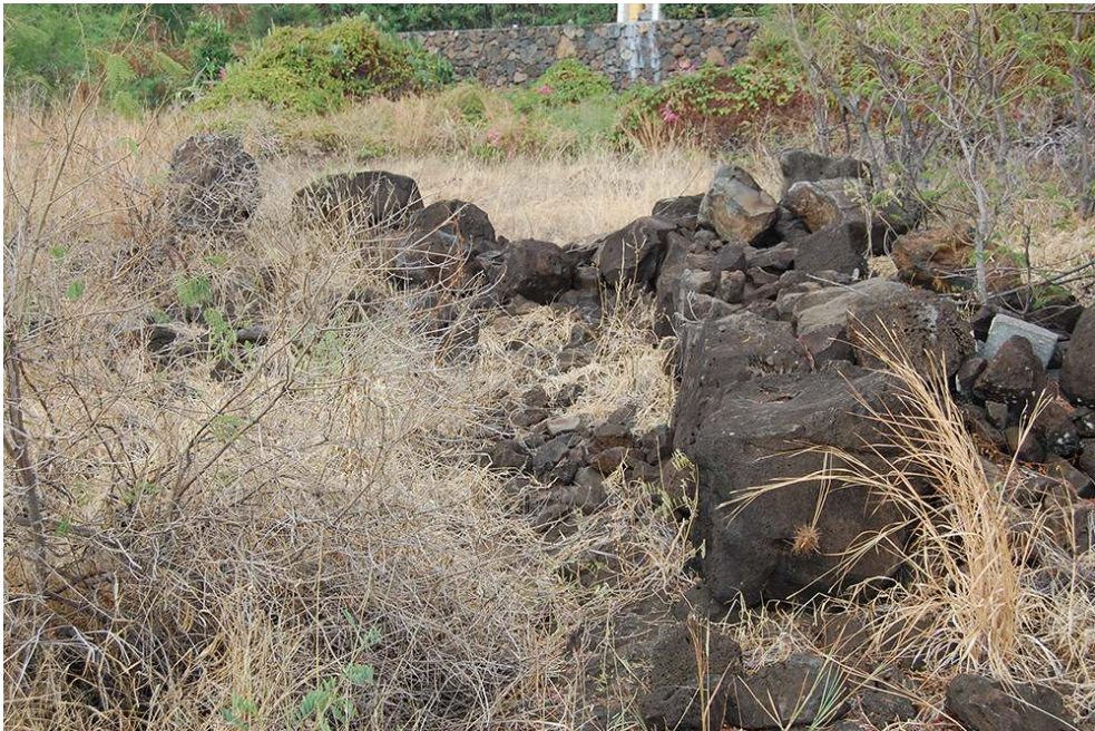
Fig. 4 – Vue d'un vestige de mur maçonné sur le site du camp dit « des engagés »
