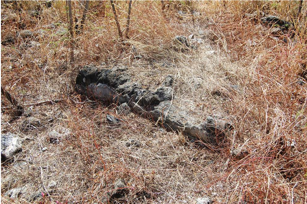
Fig. 3 – Vue d'un vestige de mur maçonné et enduit à la chaux sur le site de l'hôpital
