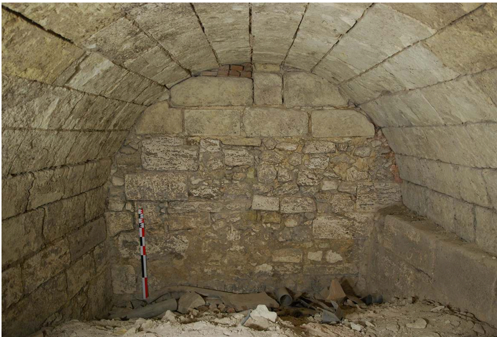
Fig. 1 – Salle voûtée de la fosse latrine sous l'escalier Louis XII (Pièce L.S. 00.04)
