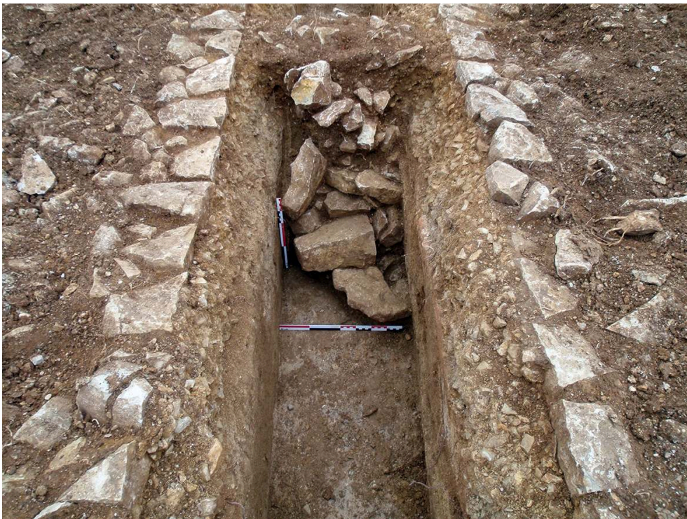
Fig. 1 – Aqueduc de Nérigny, vue de l'effondrement de la couverture du conduit d'aqueduc au point de vue SPOT06
