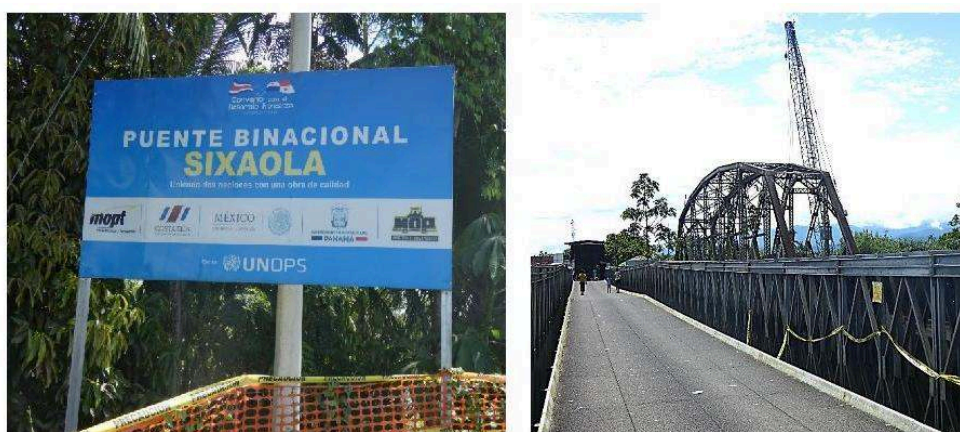
Figure 5. Pont frontalier sur le fleuve Sixaola (versant caraïbe, frontière Costa Rica-Panama).
