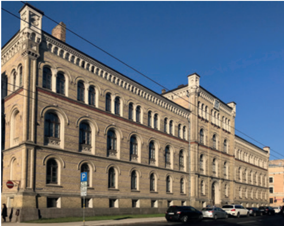
Le bâtiment de l'École polytechnique de Riga, extension le long de la rue Merķeļa (G. Hilbig, 1878)
