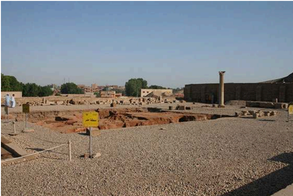
Fig. 1. État avant travaux.
