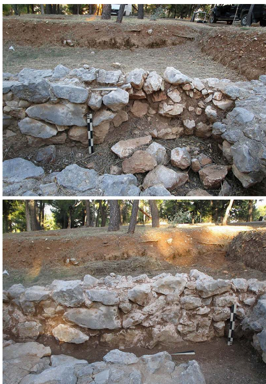
Fig. 18-19. Le mur 751 avant et après les travaux de consolidation.
