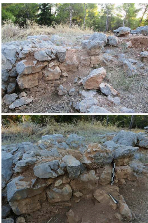
Fig. 20-21. Le parement intérieur du rempart mésohelladique avant et après les travaux de consolidation.
