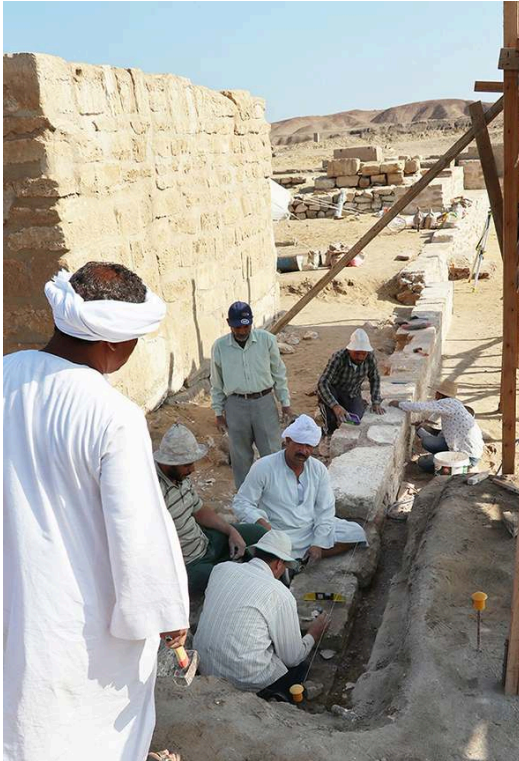
Fig. 28. Construction d'un muret de fondation au sud de la tombe de Chéchonq III, vu de l'ouest (cliché Fr. Leclère).
