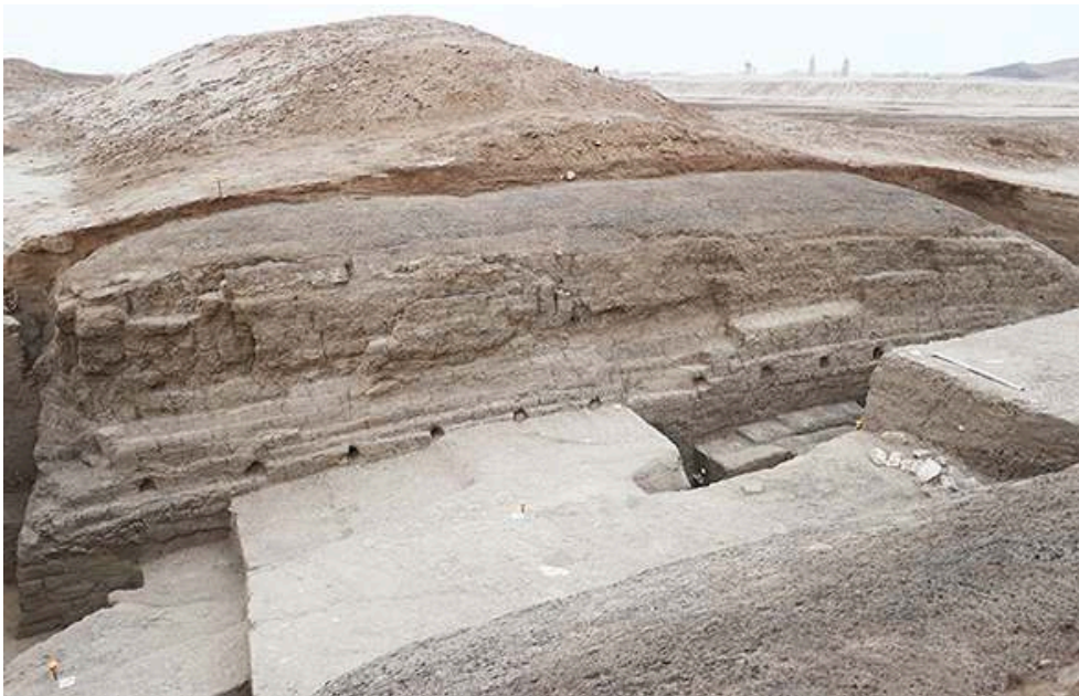
Fig. 3. Montant ouest du passage de la Porte Sud, vue de l'est ; ligne de tirants de bois dans la maçonnerie de la grande enceinte (cliché Fr. Leclère).
