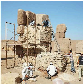
Fig. 30. Rénovation de la partie ouest du môle sud (contrefort et feuillure) de la Porte monumentale de Chéchoq III, vue du sud-est : a. Début de l'intervention ; b. Après intervention (cliché Fr. Leclère).
