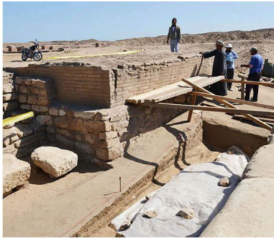
Fig. 26. Rénovation du caisson moderne de protection du mur en briques crues de la XXII e dynastie (Osorkon II) au nord-est de la tombe de Psousennès I er , vue du sud-ouest : a. État avant démontage ; b. Finitions après rénovation (cliché Fr. Leclère).
