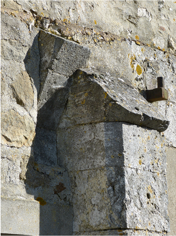
Fig. 13 – Abbaye de Preully, emplacement de la porterie médiévale initiale. Détail du piédroit de la porte charretière
