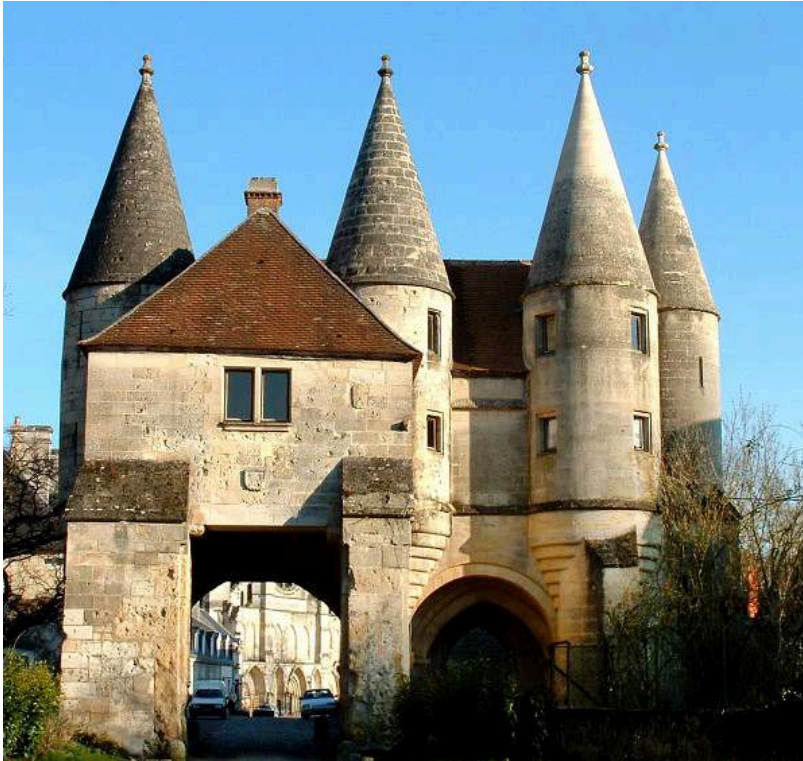
Fig. 9 – Abbaye de Longpont. Vue de la façade extérieure de la porterie, état actuel
