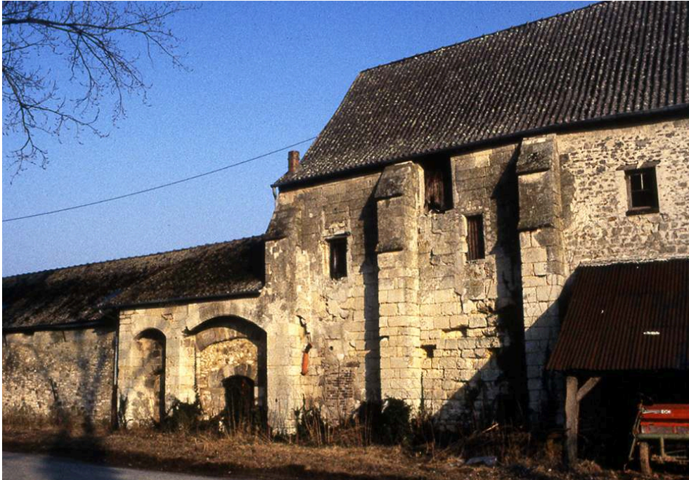
Fig. 16 – Grange de Fourchet. Vue extérieure de la porterie avec des mâchicoulis sur arc
