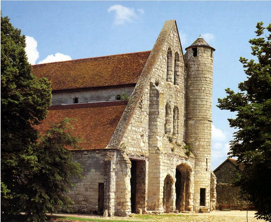
Fig. 18 – Grange de Vaulerent. Vue du mur-pignon sud-ouest avec tour adossée
