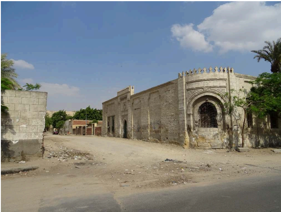
3.a. En semaine, la rue Ihn el Fared complètement déserte. Source : auteurs, 08/05/2019.
