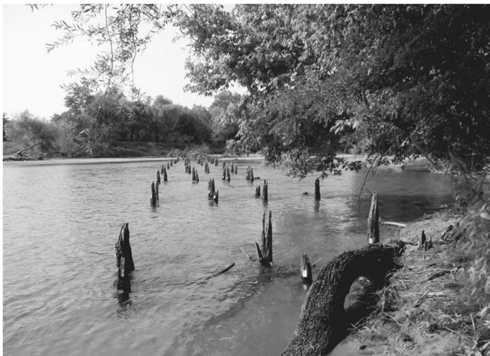
Fig. 1 – Les pieux du pont médiéval entre La Charité-sur-Loire et La Chapelle-Montlinard en période de basses eaux
