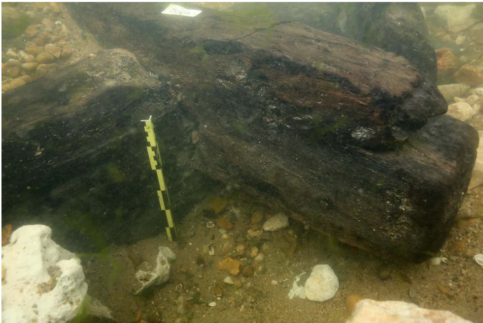
Fig. 6 – Enture à mi-bois de la structure 39 d'une base de pile de pont mise au jour en 2017
