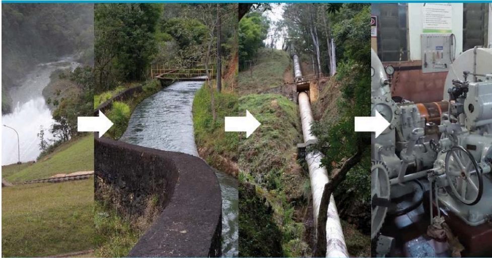
Figura 3: O caminho desde a barragem jogando água no rio pela sua válvula, a passagem pelo canal de adução e o conduto forçado até chegar na PCH. Fonte: Situated Consultoria e Pesquisa.
