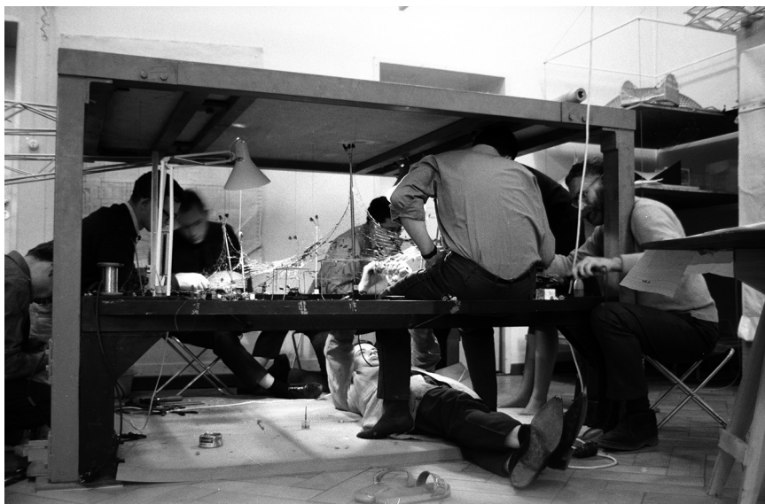
Ill. 3 : Frei Otto et son équipe travaillent sur la grande maquette expérimentale pour le pavillon allemand, exposition de 1967 à Montréal, Institute for Lightweight Structures (IL) de l'Université de Stuttgart, 1965-66. © saai / Archive for Architecture and Civil Engineering, Karlsruhe Institute for Technology.
