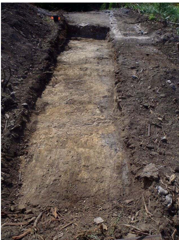
Fig. 3 – Tranchée vers l'ouest
