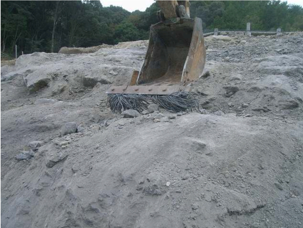
Figure 11. Godet de la pelleuse sur lequel une brosse métallique a été fixée
