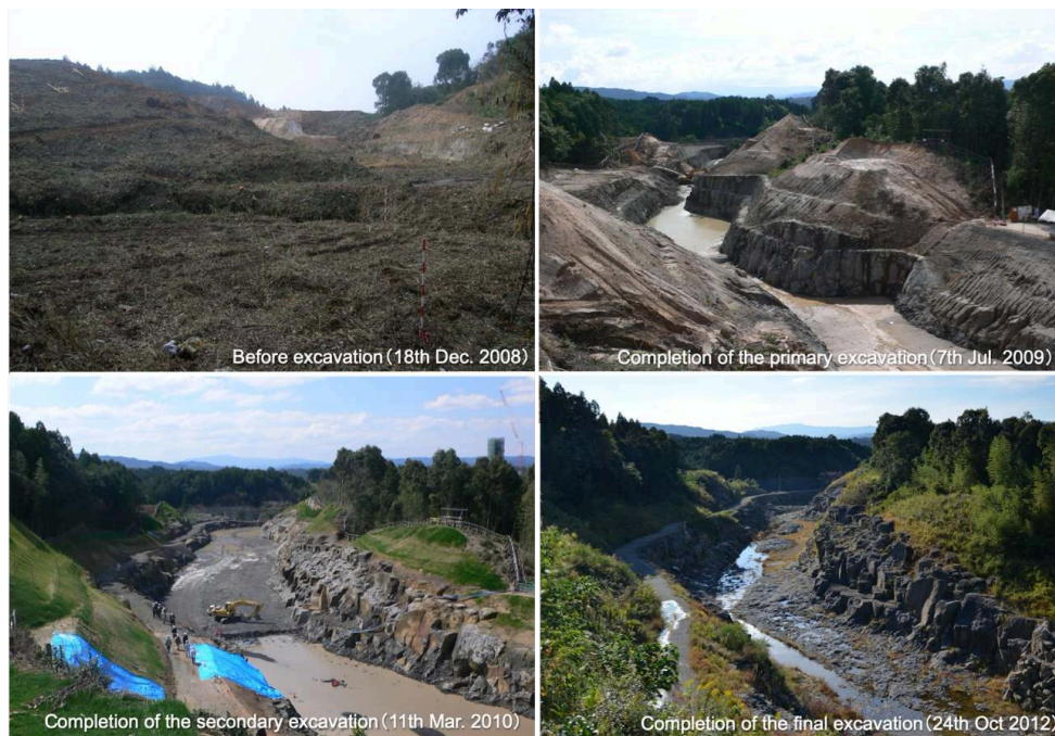
Figure 9. Processus de travaux
