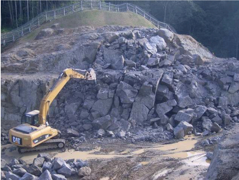
Figure 10. Évacuation soignée suite au dynamitage
