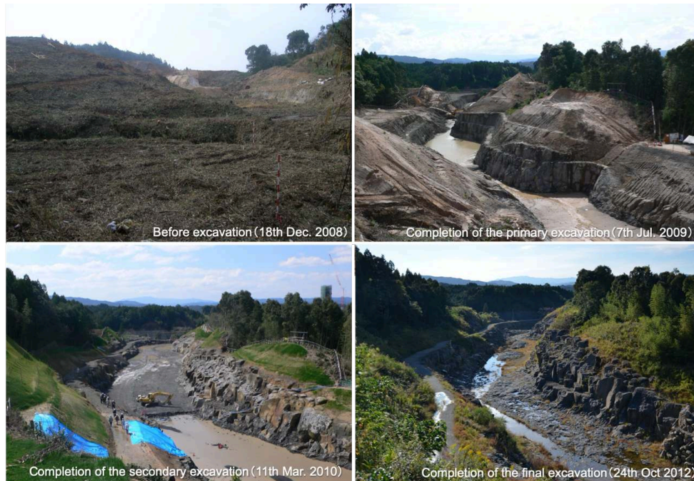
図9 施工のプロセス
