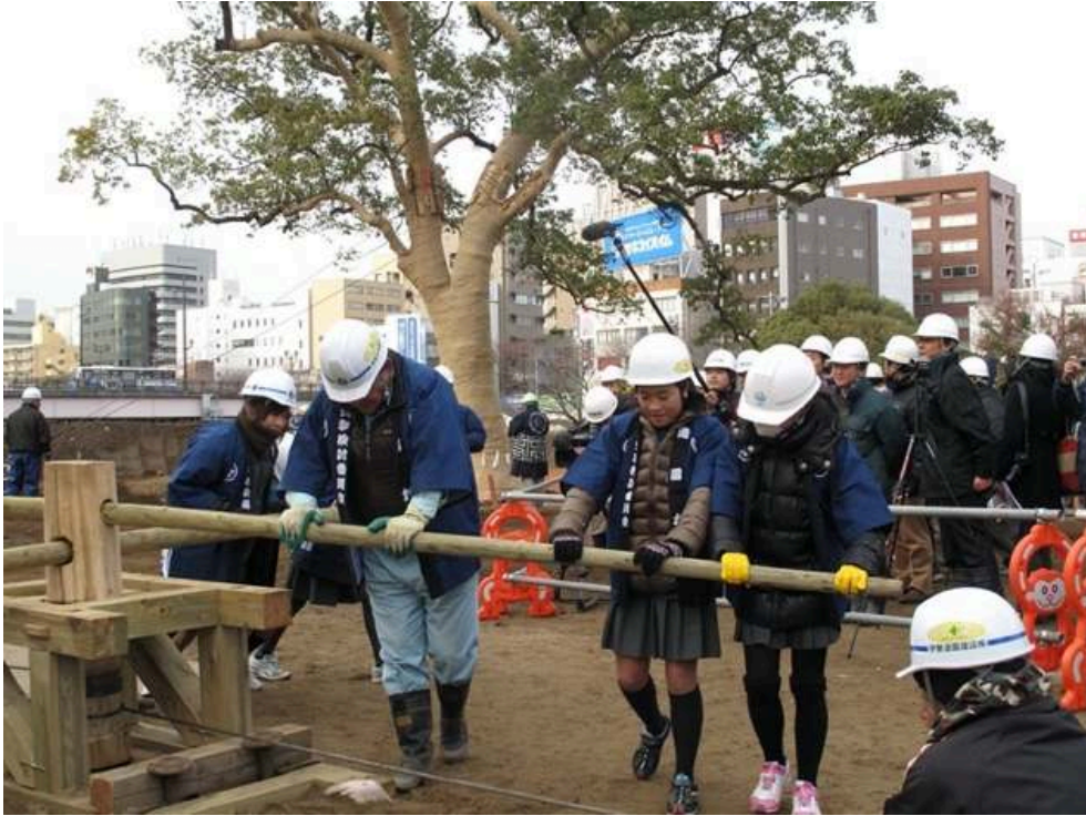
図19 立曳き工事の様子
