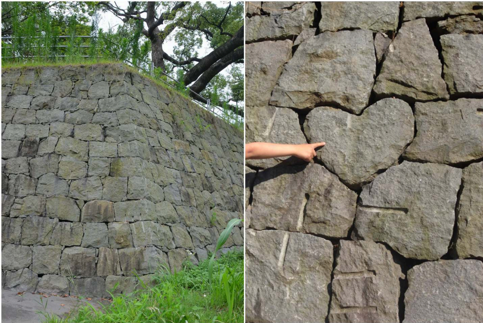
図22 算木積みと石垣に埋め込まれたハート型の石
