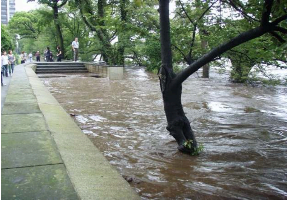
図21 九州北部豪雨（2012）時のパラペット
