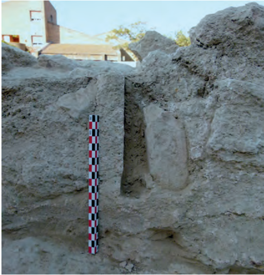
Fig. 109. Bâtiment 11, pièce 38. Négatif d'un tasseau dans le parement est du mur 154 (cliché Br. Chevaux).
