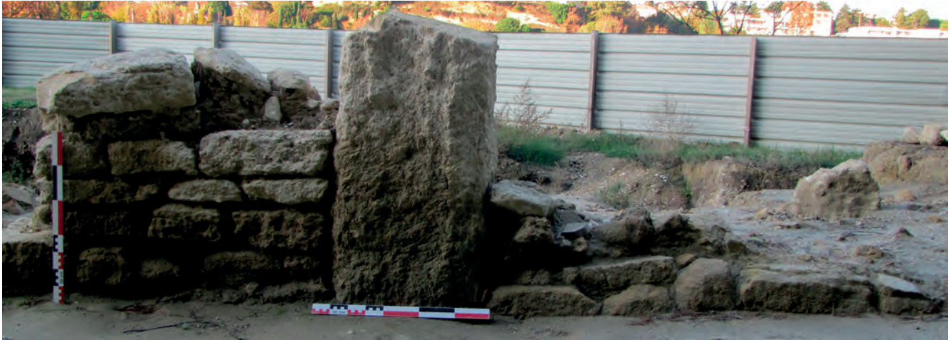
Fig. 140. Pièce 20. Parement est du mur 46. Le bloc vertical délimite peut-être le piédroit gauche d'une ouverture murée (cliché Fr. Marty).
