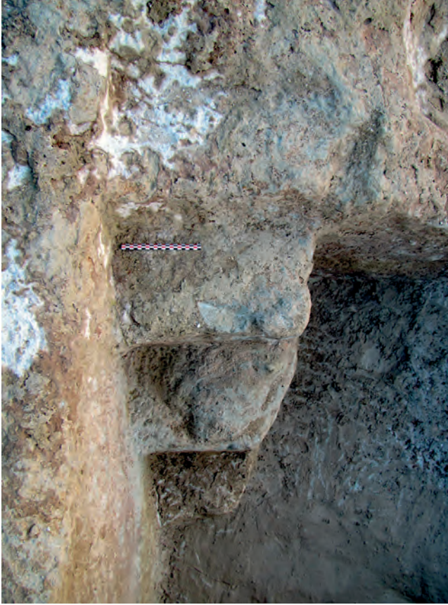
Fig. 115. Bâtiment 11. Escalier de la cave 215 vu du nord (cliché Fr. Marty).
