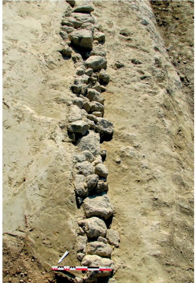
Fig. 58. Mur 2239 en bordure de la voie 2192 (à droite), vu du nord-ouest (cliché Fr. Marty).
