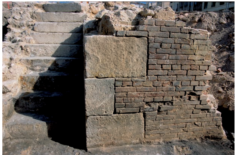
Fig. 59. L'escalier qui conduit au sous-sol du bâtiment F, vu de l'ouest (photo S. Mathie, Inrap).
