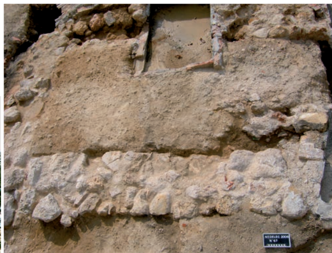
Fig. 73. Détail de fondation de mur du bâtiment G, mur est (photo S. Mathie, Inrap).
