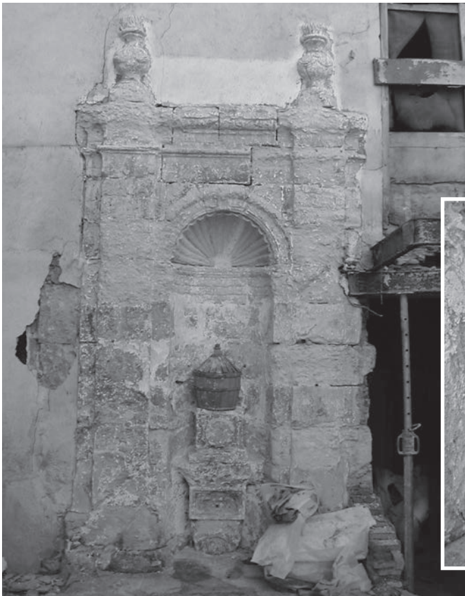
Fig. 47. Fontaine en cours de restauration et de dégagement rue Bernard-du-Bois (photo C. d'Ortoli).
