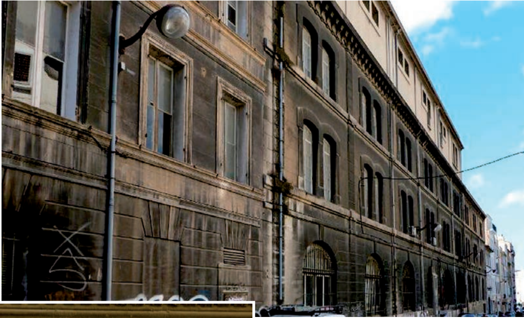
Fig. 99. Les façades des anciens établissements Velten, rue Bernard-du-Bois (Photo Ingrid Sénépart).
