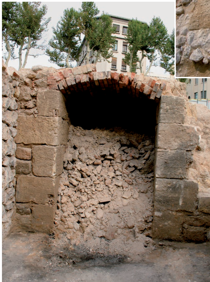
Fig. 72. La porte d'accès à la soute T1 par le sous-sol du bâtiment F (photo Fr. Parent, Inrap).
