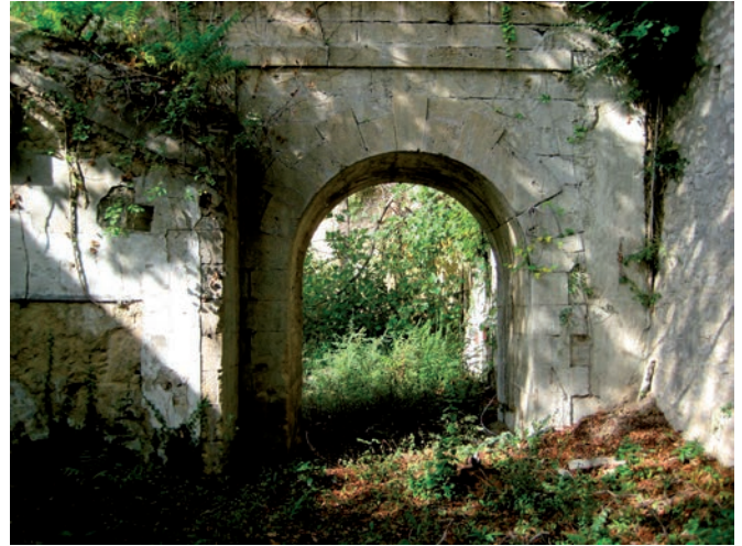
Fig. 93. Arc qui soutenait un des canaux en provenance du canal souterrain (photo C. Castrucci, Inrap).
