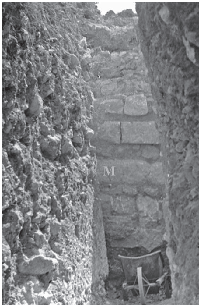
Fig. 111. Tranchée de fouille transversale (1939) montrant le parement extérieur du rempart. (Cliché Fonds Fernand Benoit, Palais du Roure, Avignon). Les fragments de stèles sont disposés alternativement en lits de carreaux et de boutisses. En M, le « menhir » dans le parement en position de carreau.
