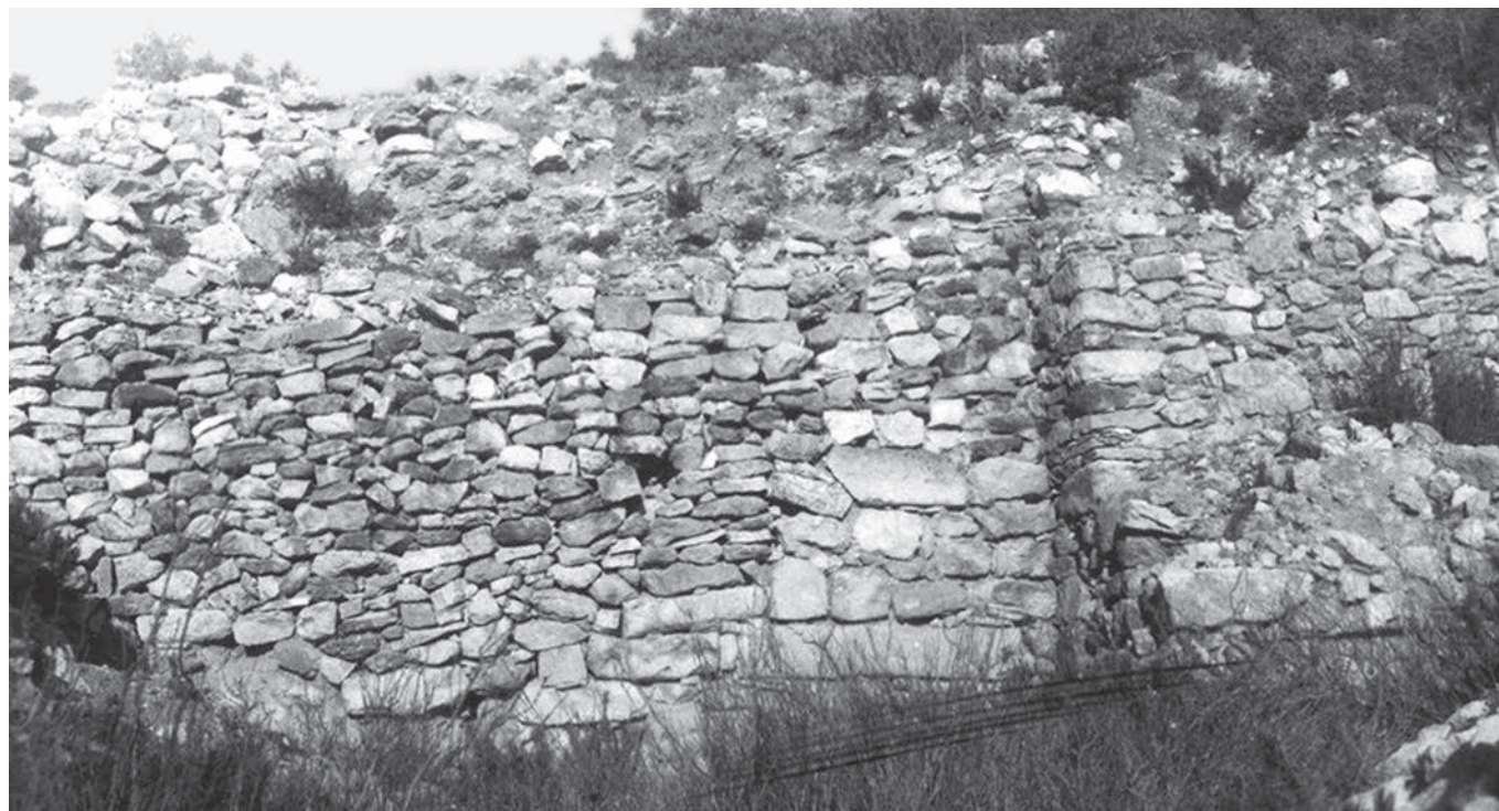
Fig. 112. Vue de la section du rempart fouillée par Fernand Benoit entre 1939 et 1942. Les différences d'appareil soulignent la partie reconstruite après la fouille (cliché Aubert 1956, Fonds Fernand Benoit, Palais du Roure, Avignon).
