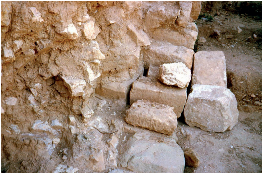
Fig. 125. Base du parement extérieur du rempart 6119 (zone Z06). Stèles en boutisse maintenant son remplissage intérieur de blocs et de terre argileuse beige et de blocs.
