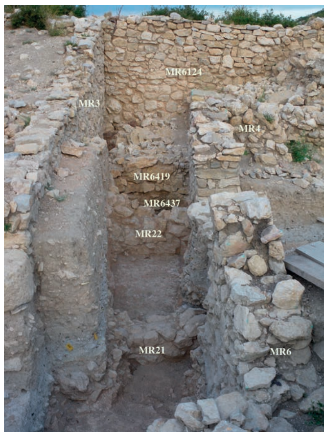
Fig. 65. Murs (MR21 et 22) d'une pièce du V e s. av. J.-C. accolée au rempart archaïque MR6437 (Zone Z06, secteurs 6 et 8, vue E-O). Tous les autres murs appartiennent à la maison à pièces multiples du I er s. av. J.-C.
