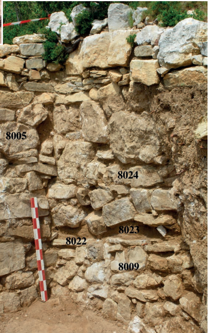
Fig. 74. Les parties superposées composant le parement du rempart MR8009, de part et d'autre du lit d'égalisation (Us 8022) et de la couche d'argile jaune (Us 8023). À gauche, début du parement de la tour semi-cylindrique MR8005. Vue SO-NE.
