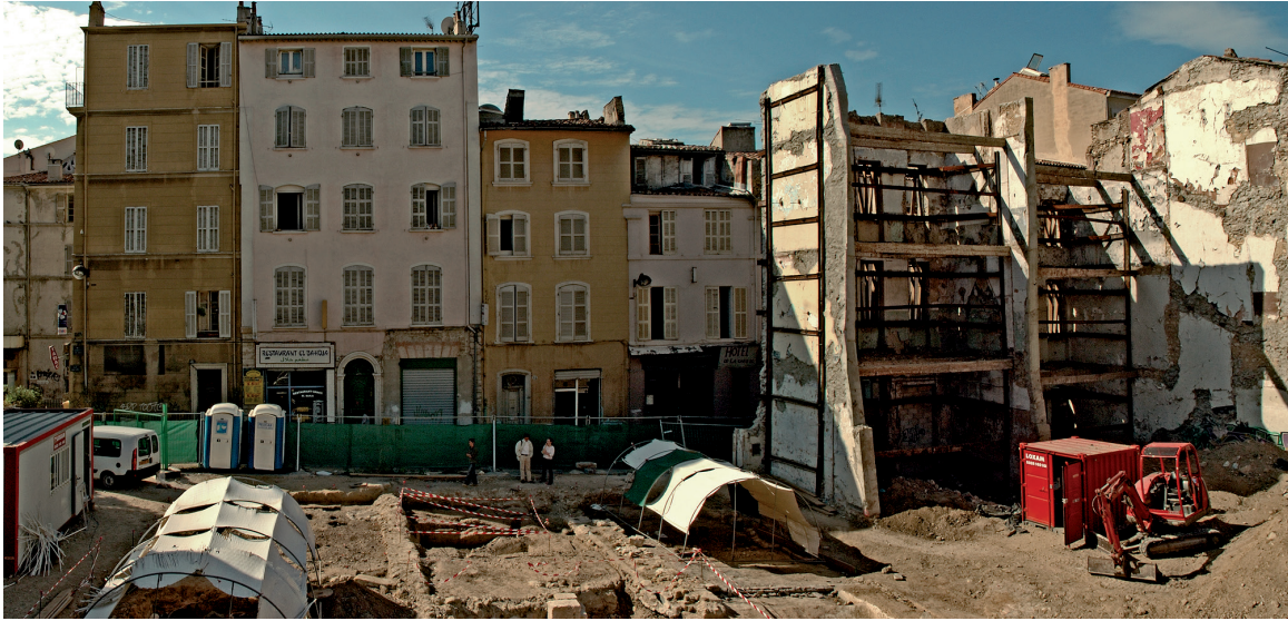
Fig. 6. Le site de la rue Bernard-du-Bois ; les fondations des maisons modernes sont implantées directement dans les sols archéologiques antiques et néolithiques qui sont à un mètre à peine en-dessous du niveau de la rue (cliché Ch. Galatry).
