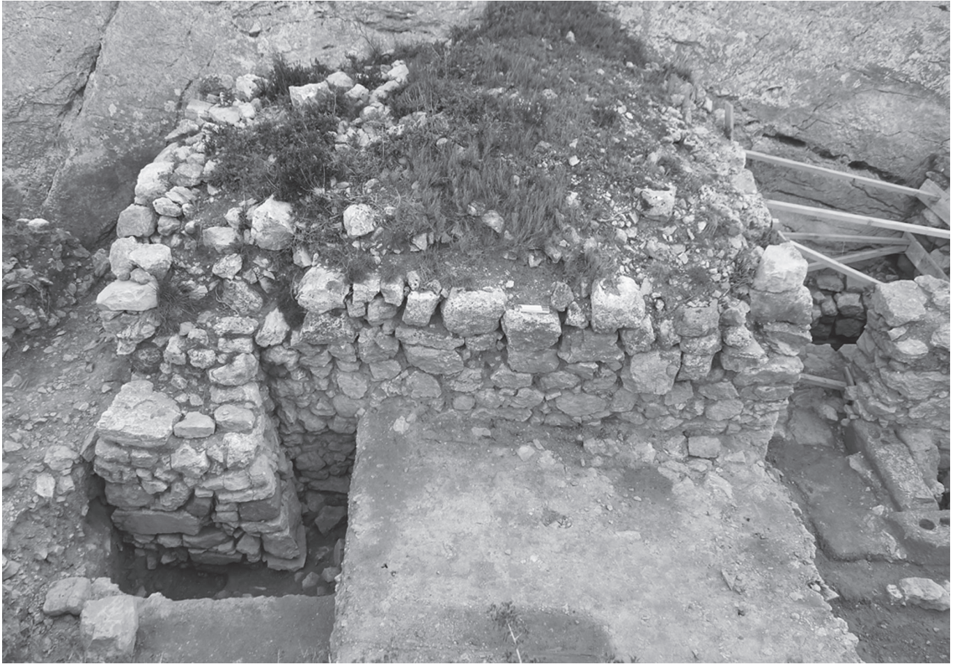
Fig. 108. La tour tardive du secteur 2B au pied de la falaise, vue du nord.
