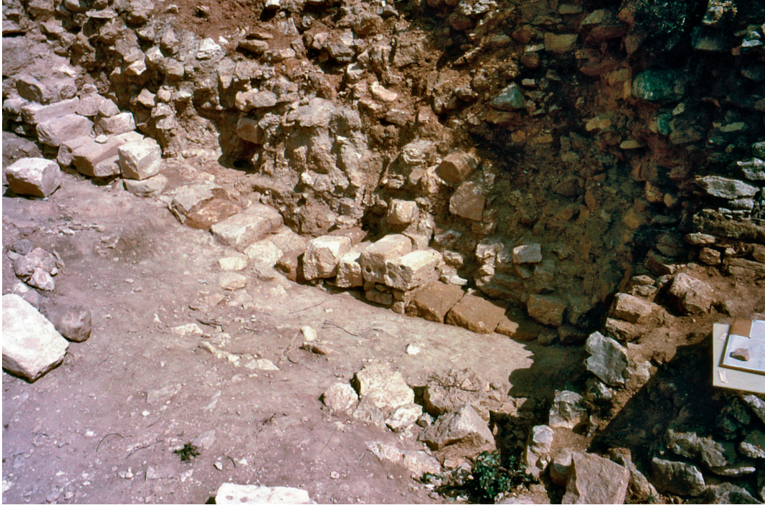
Fig. 124. Stèles disposées en boutisse dans le parement extérieur du rempart MR6119 (Zone Z06). Les contrastes de couleur permettent de distinguer le remplissage interne du rempart (Us 6122, en beige) du talus d'argile (Us 6101 et suivantes, en rouge violacé) accolé au parement intérieur.
