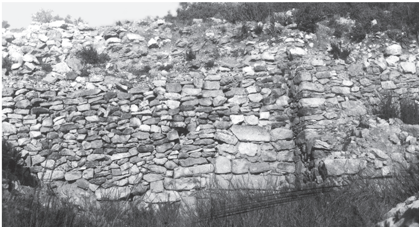
Fig. 112. Vue de la section du rempart fouillée par Fernand Benoit entre 1939 et 1942. Les différences d'appareil soulignent la partie reconstruite après la fouille (cliché Aubert 1956, Fonds Fernand Benoit, Palais du Roure, Avignon).
